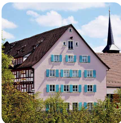
Alte Brunnengasse 1, 1a und 3
