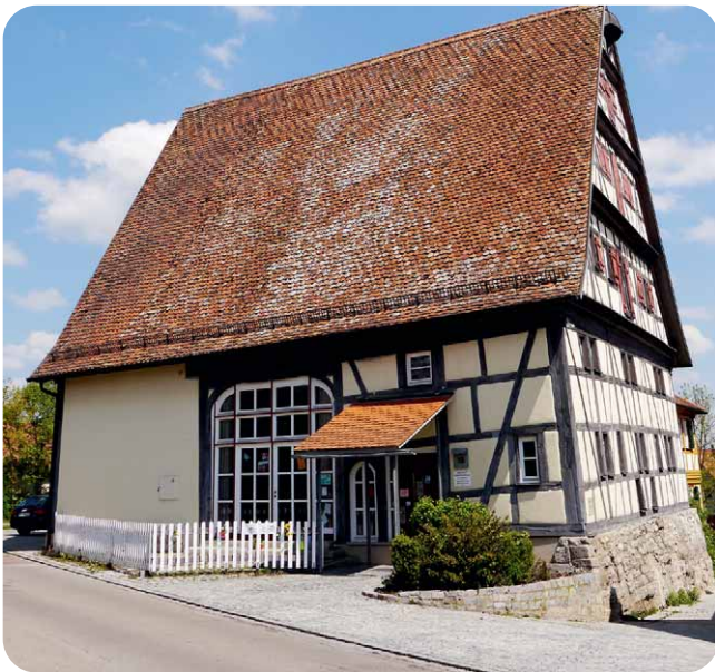
Die ehemalige Fachwerk-Scheune am Eck Spitalwall / An der Heuwaag sticht sofort ins Auge.
